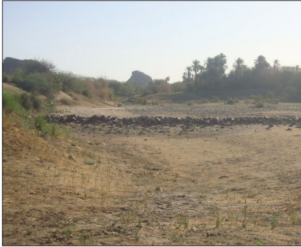
اللوحة ٥: جدار حجري بني حديثاً لحجز المياه في مجرى موسمي للنيل بالقرب من قرية فاد
