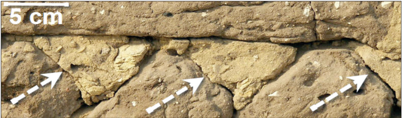
اللوحة ٩: مونة الاستعداد على شكل مثلث مقلوب تمهيدا لوضع قوالب الطوب الطيني بالمدماك الأول.
