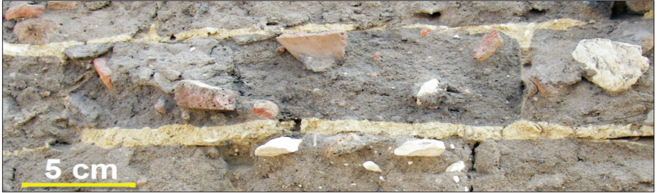
اللوحة ٥: يوضح المواد المضافة (كسر فخار، كسر حجر).
