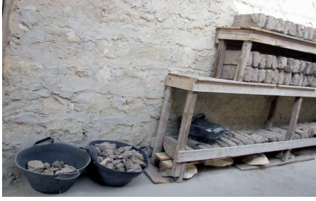
اللوحة ٢٨: طريقة تخزين قوالب الطيني والمونة وطبقات الملاط (اللياسة)
