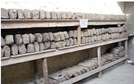
اللوحة ٢٧: طريقة تخزين قوالب الطيني طبقاً لموقع كل مدماك في الجدار (الجدار الشرقي)
