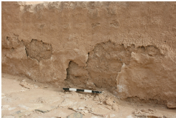
اللوحة ٥: أ، ب: جدران اللبن وبها تآكل وانفصال طبقة السطح.
