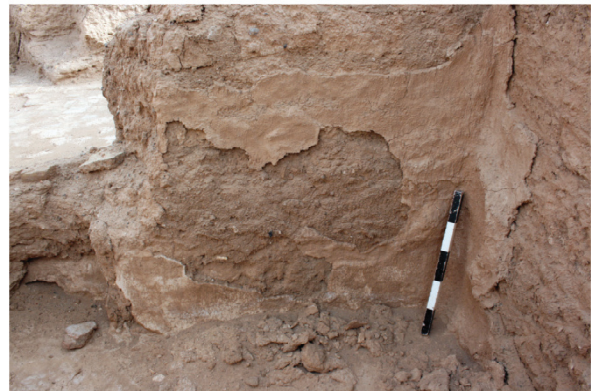
اللوحة ٥: أ، ب: جدران اللبن وبها تآكل وانفصال طبقة السطح.
