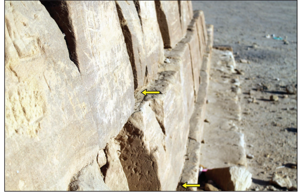
اللوحة ٢٥: المسافة بين الكتل السفلى والتي تعلوها ١٠ اسم لتنفيذ التدرج في الهرم.
