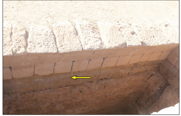
اللوحة ١٩: وضع المعالجة بالحجارة بعد الطبقة الثابتة.
