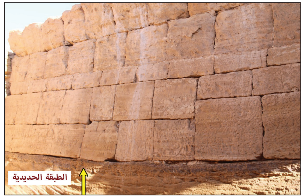
اللوحة ٢٠: استخدام الحجارة أعلى الطبقة الحديدية الثابتة بالهرم رقم ١٨ شبتكو.
