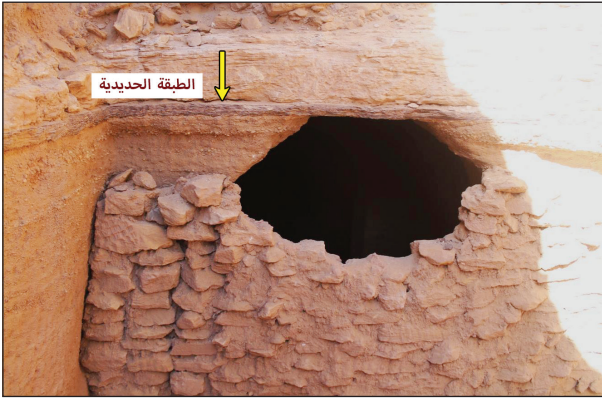
اللوحه ٢٢: معالجة الأقواس أسفل الطبقة الحديدية بالهرم رقم ٤.
