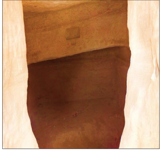
اللوحه ٤: عمق الخزان والظمي المتراكم بداخله، وإلى اليسار نحت كان يُثبت عليه نقش تأسيسي أو تشريعي، مع أداة قياس المياه بداخل الخزان.
